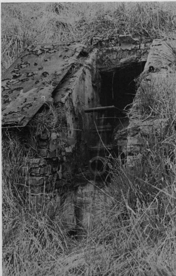
In de helling van de oever was een ijzeren val... Daaronder zat een leiding met een kraan.
