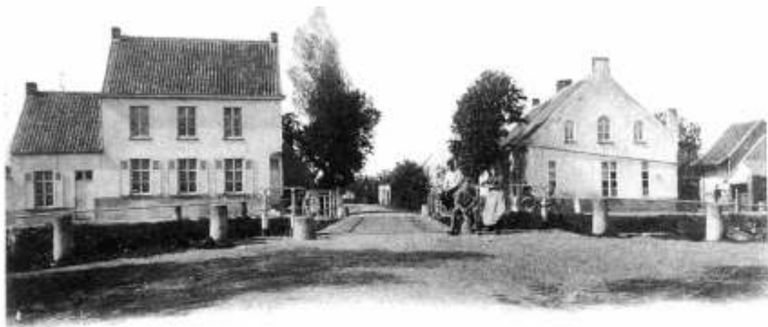
Wachtebeke. — De Overledebrug — Le pont d'Overlede
