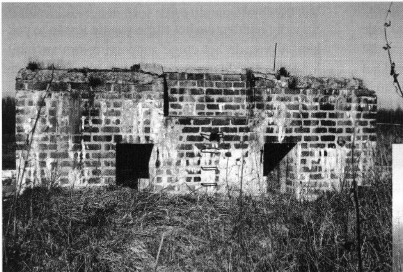
Deze bunker op de zuidzijde van de Moervaart hoorde bij de Hollandlinie.
