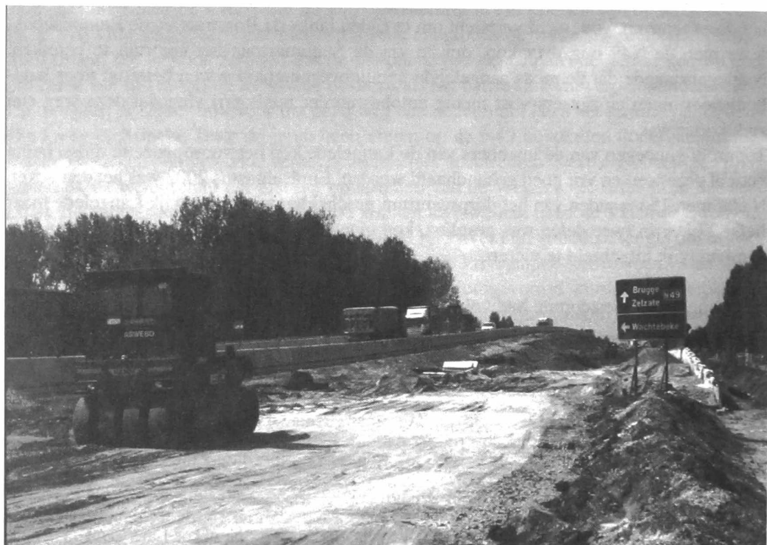
(Foto: Eddy Van Acker) zomer 2002 De aanleg van het noordelijk rijvak richting kust.
