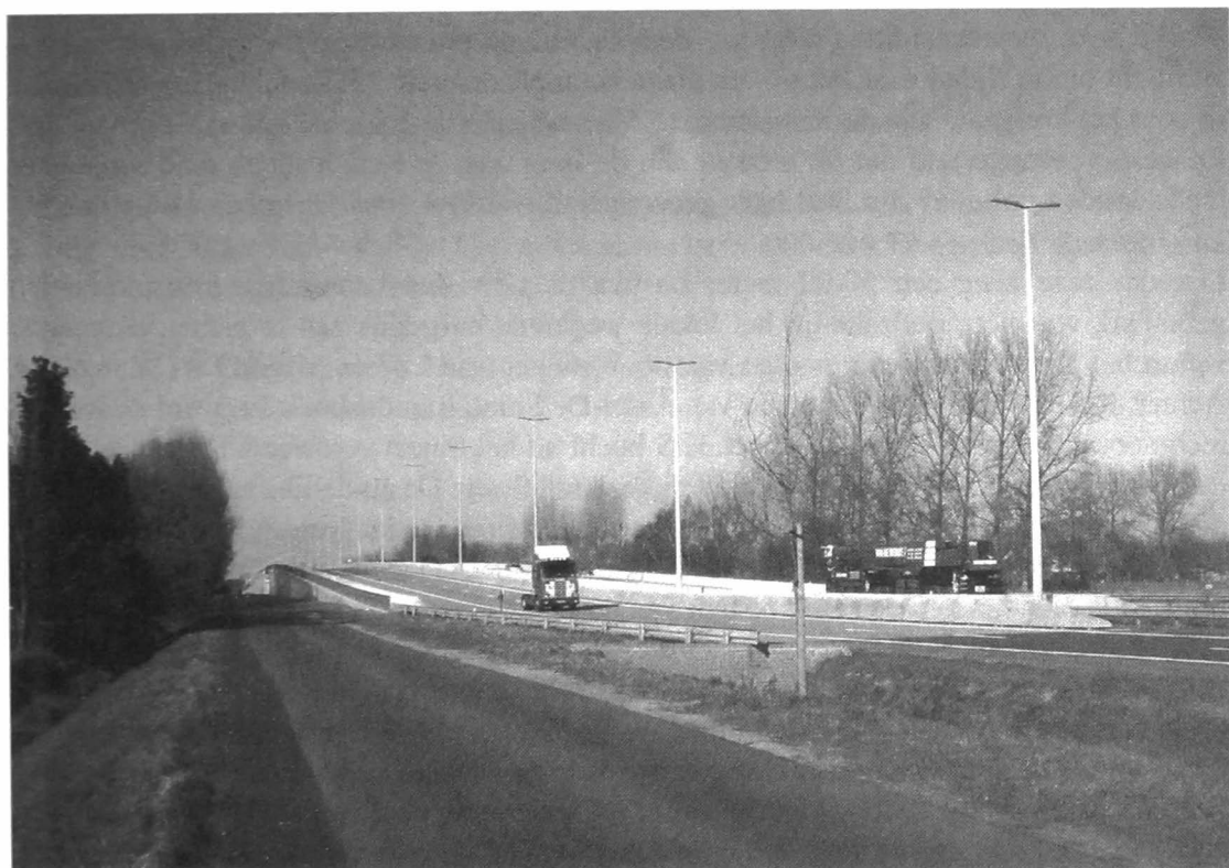
(Foto: Eddy Van Acker) Februari 2004 Het afgewerkte viaduct van de Langelede.
