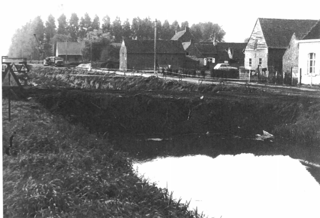
(Verz. André De Bruyne - Angela Steel) Oktober 1975 Noordelijke afdamming van de Langelede.
